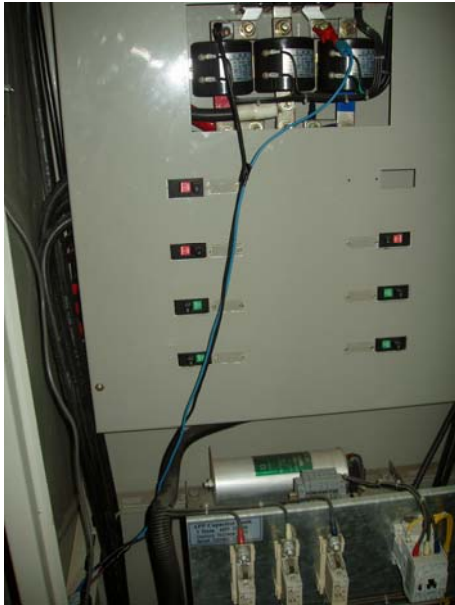
(五樓電力室 PLC Coupler 架設)
